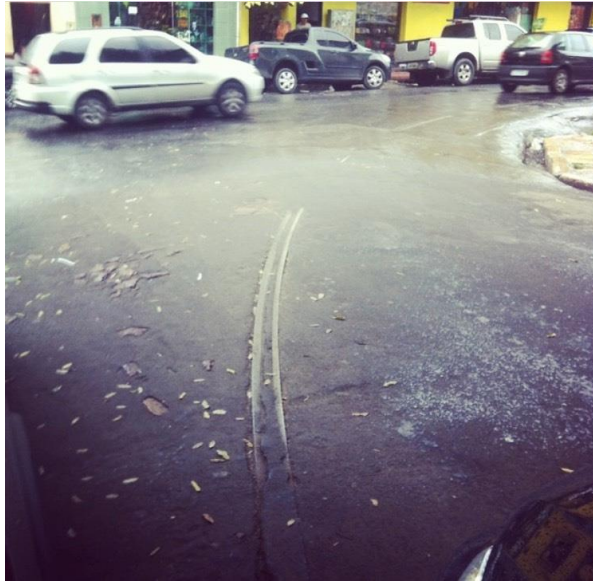
Figura C.03: Trilhos de bondes expostos em 2014. Rua Leovegildo Coelho. Autor: Frederico Cesarino (2014).
