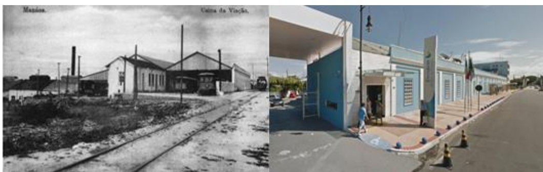
Figura C.02: Garagem dos bondes (1900) e atual sede da Eletrobras Distribuição Amazonas (2018). Fonte: Frederico Cesarino (2018).
