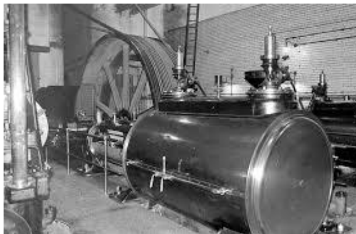
Figura 3.06: motor tipo Compound utilizado na Usina do Plano Inclinado em 1911. Fonte: Acervo Eletrobras Distribuição Amazonas.
