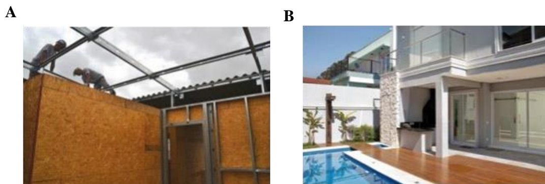
Figura 8. Sistema Light Steel Framing. A, sendo instalado, B – Sistema pronto, resultado final.
