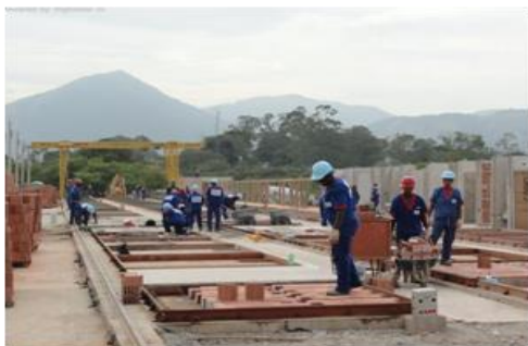
Figura 7. Imagens dos painéis autoportantes. A- Fabricação de painéis, B - Painéis prontos.
