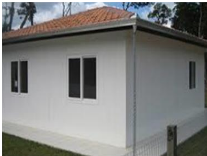
Figura 10. Sistema construtivo PVC e concreto.
