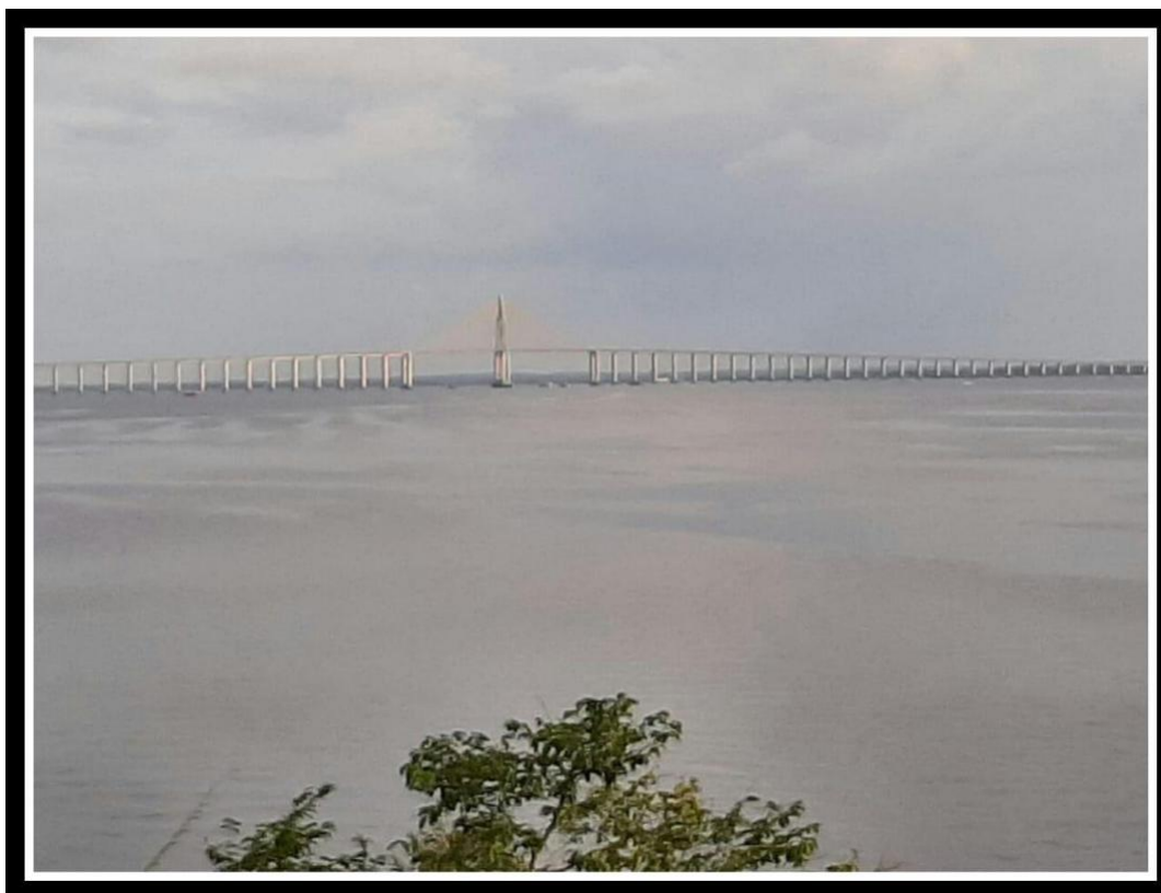
Figura 16: Ponte Phelippe Daou em Manaus, AM
