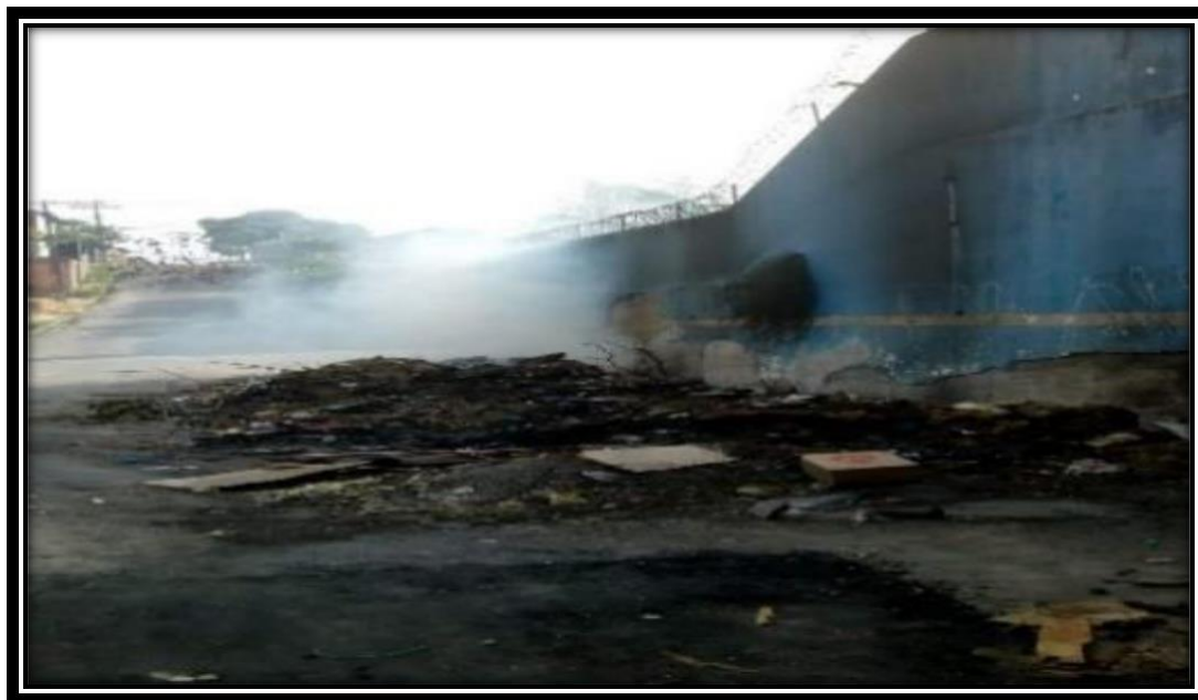
Figura 19: Lixo e queimada no muro da Escola Municipal Arthur Engrácio da Silva na cidade de Manaus, AM
