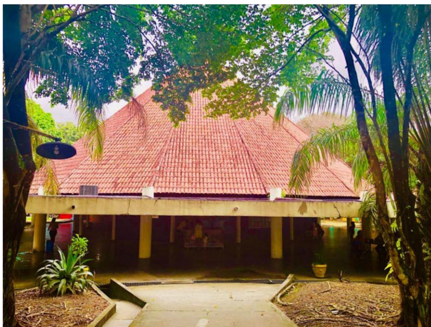
Figura 2 – Fotografia do Espaço Externo da DDPM – Frente / Hall
