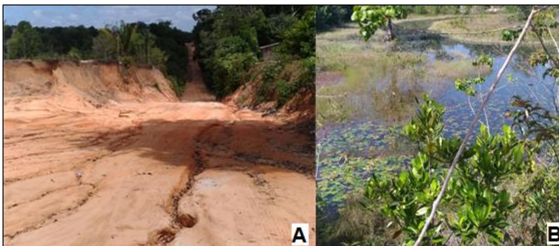
Figura 21. A - Ramal São Francisco em estado precário, devido ao inverno e passagem de caminhões pesados; B – Formação de lagos ao lado do ramal, devido ao aterramento dos igarapés.
