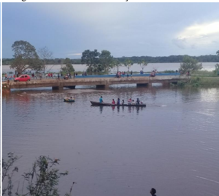
Figura 3 – Ponte de Umariacú II
