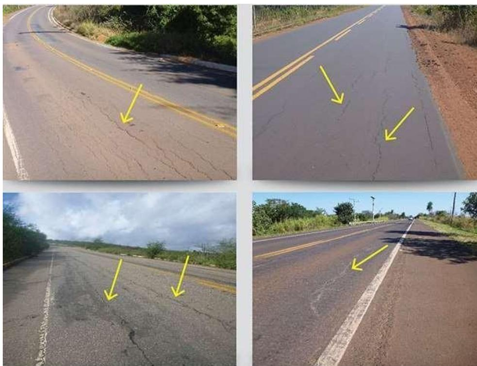
**Figura 6 - Fissura em revestimento asfáltico**
