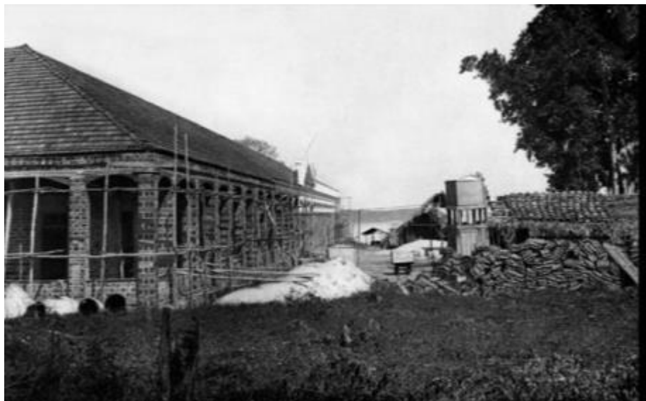
Figura 6 - Leprosaria de Paricatuba em construção Fonte: Instituto Durango Duarte, 2020
