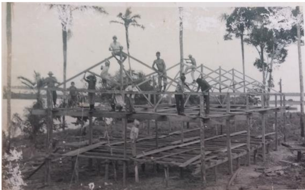
Figura 23 - Ex-internos trabalhando na construção de uma casa Fonte: Maria do Carmo Fontes.
