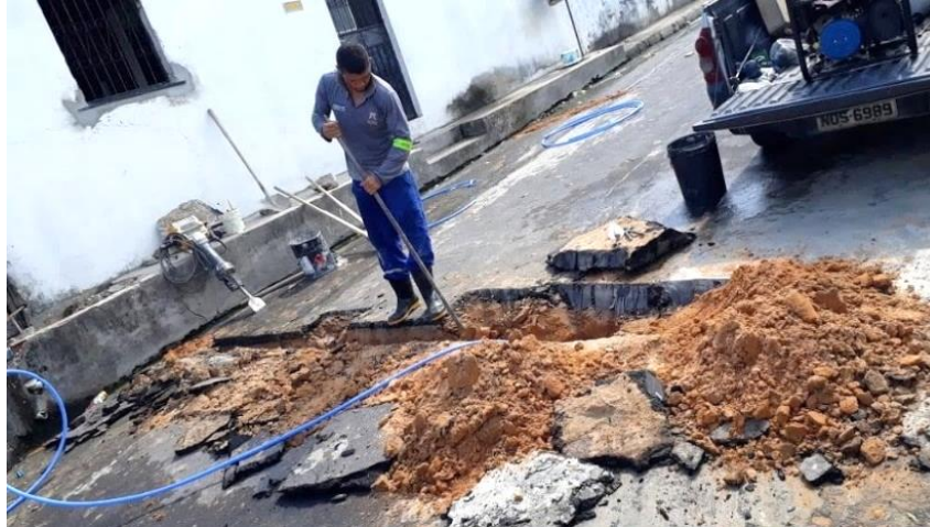
Figura 1.1- Instalação de ramal predial na via pavimentada em Manaus
