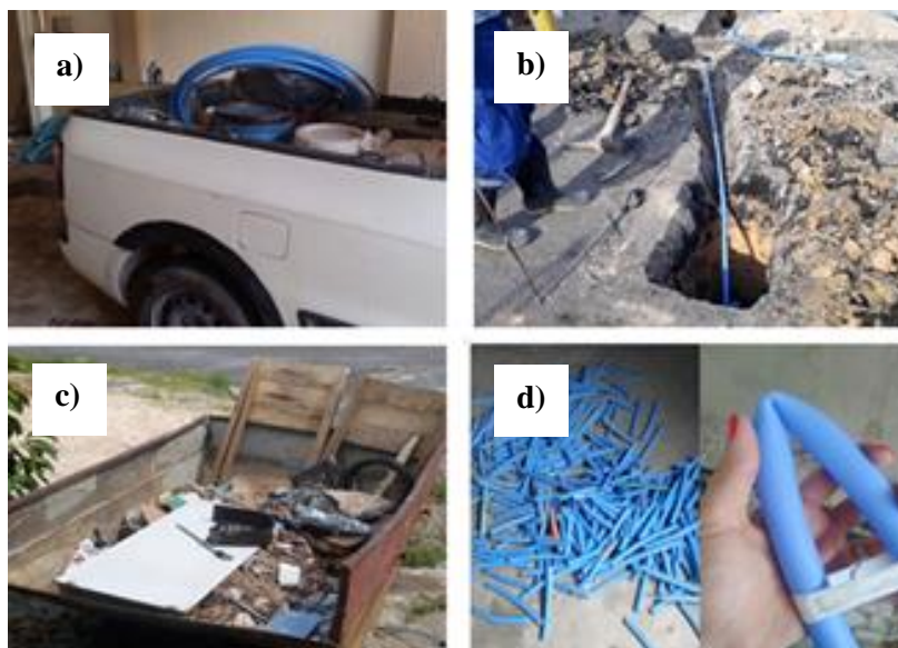
Figura 3.3- Uso de tubo de PEAD em serviços de ligação de água: (a) tubos de PEAD separados para os serviços, (b) tubo de PEAD no ramal predial de ligação, (c) descarte de pedaços de tubo de PEAD em caixas coletoras, após consumo, (d) resíduos de tubo PEAD manipulado
