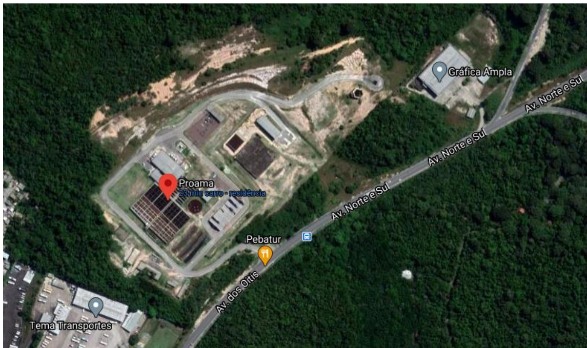
Figura 14. Localização da E.T.A - Ponta das Lajes-Manaus-AM ( 3^{\circ}05'25.9''S e 59^{\circ}56'02.7''W ).
