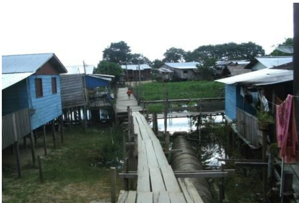
Figura 12 - Lançamento de esgoto sanitário Fonte. Hamilton (2018)
