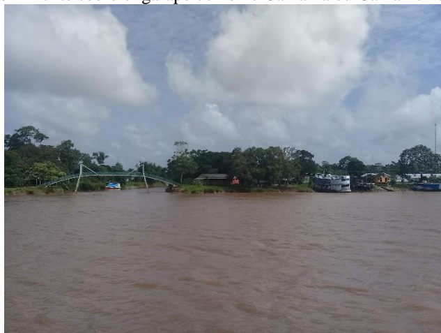
Figura 7- Ponte sobre o igarapé de nome Cainamã ou Cainamé na CNSG
