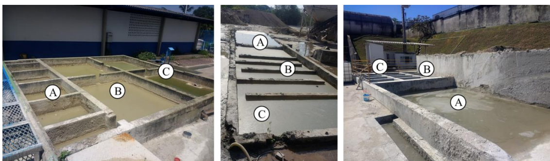
Figura 10 – Tanques de sedimentação - à esquerda: CDC K; no meio: CDC P e à direita: CDC S; pontos de coleta: (A) entrada do tanque, (B) meio do tanque e (C) saída do tanque.
