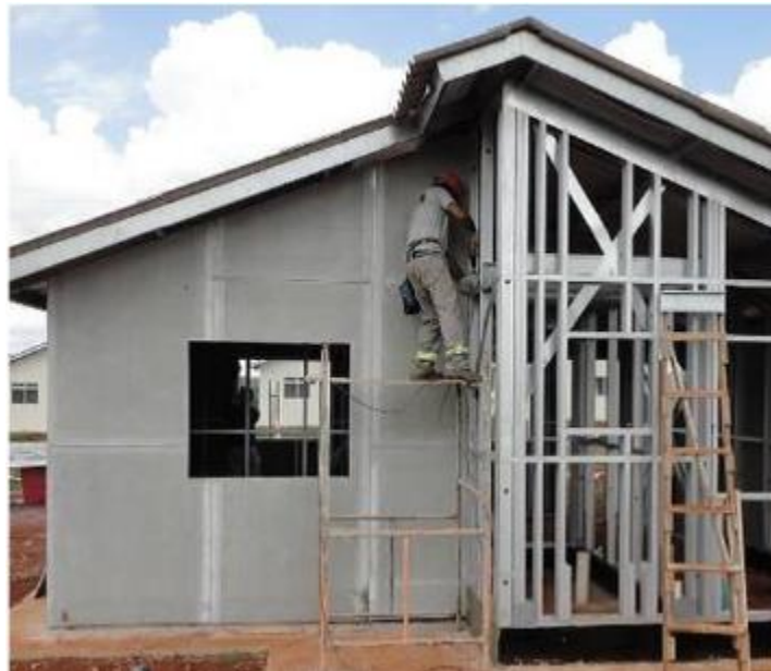
Figura 14 – Modelo de construção seca
