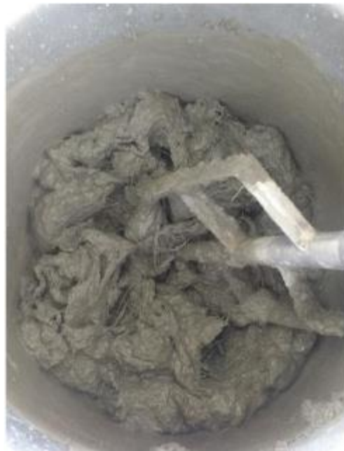
Figura 27 – Colocação das fibras no misturador até homogeneização
