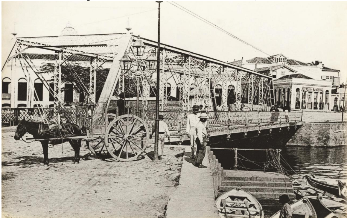
Figura 26 - Ponte de ferro dos Remédios (1896), Manaus/AM
