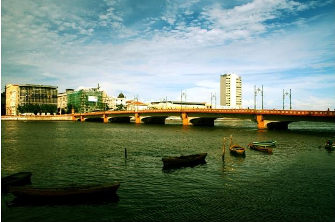
Figura 21 - Ponte Maurício de Nassau - Recife/PE
