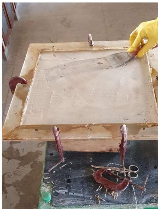
Figura 34 - Regularização de camada cimentícia
