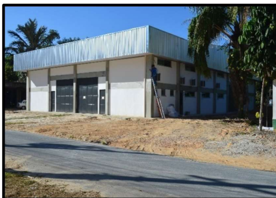
Figura 57: Prédio cedido pelo DEMAT Crédito: Acervo fotográfico do Laboratório, 2013
