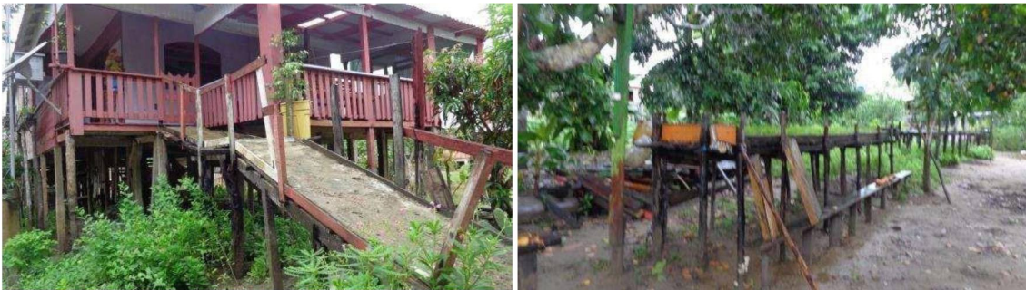
Figura 31. Registro de estruturas suspensas, devido as cheias (moradia e jirais suspensos) na comunidade Nossa Senhora de Nazaré no Distrito da Terra Nova.
