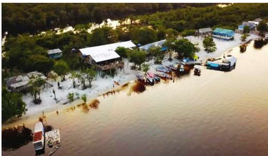
Figura 12: Vista aérea da comunidade do Daracué Fonte: Pousada Rei da Amazônia
