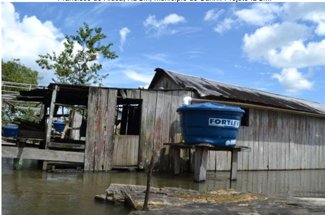
Figura 25: Sistema simplificado de coleta doméstica de água da chuva, comunidade São Francisco do Aiucá, RDSM, município de Uarini. Projeto IDSM.
