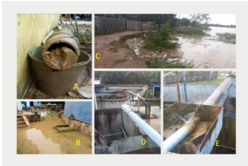
Figura 11 - Montagem a partir de imagens tiradas na estação de tratamento de água - ETA do município de Boca do Acre.
