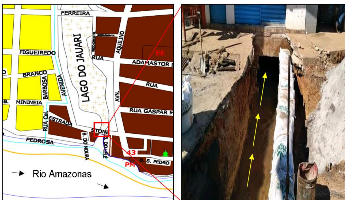
Figura 45 - Desobstrução no sentido transversal na Rua Estada Stone – Bairro do Jauari.
