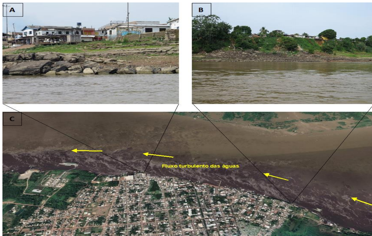
Figura 37 - Presença de rochas na frente da cidade e fluxos turbulentos das águas.
