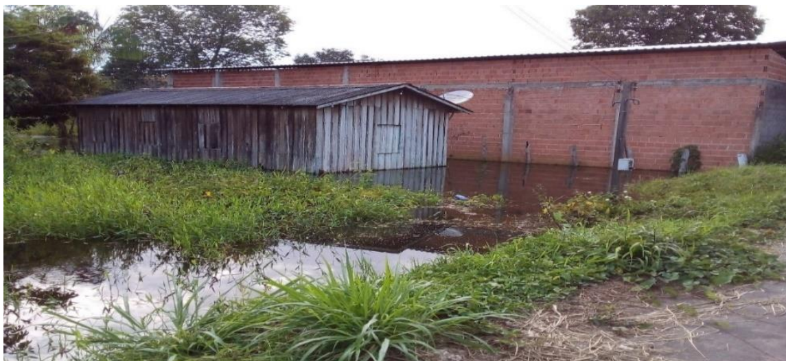
Figura 44 - Moradias tomadas pelas águas na rua Rio Solimões, bairro Mamoud Amed, 2021.
