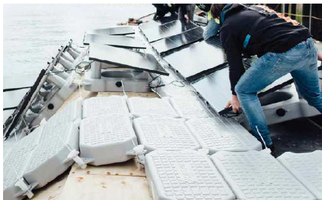
Figura 8 - Montagem e lançamento de flutuadores
