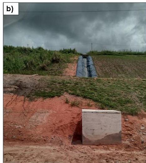
Figura 13: Drenos do Sistema Sub-Superficial do ARSM: a) Drenos de chorume sobre as células (horizontais); b) Drenos definitivos de água pluviais
