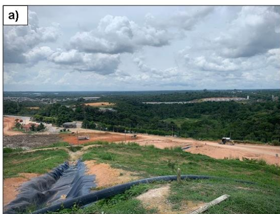
Figura 13: Drenos do Sistema Sub-Superficial do ARSM: a) Drenos de chorume sobre as células (horizontais); b) Drenos definitivos de água pluviais
