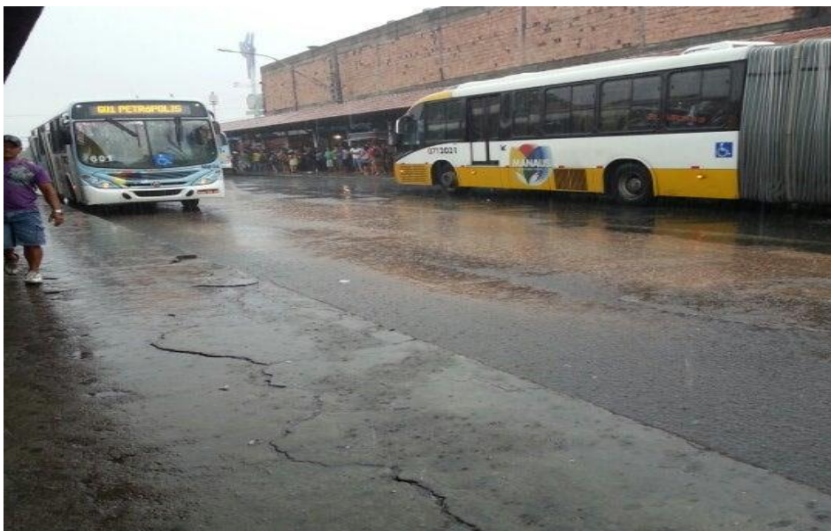
Figura 6 – Estrutura antiga do T2
