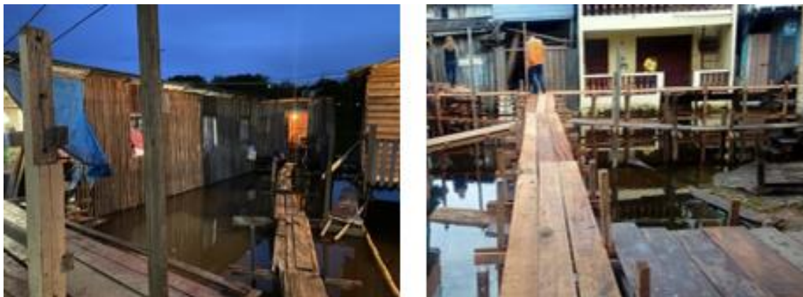
Figura 17 - Construções de pontes de acesso nos bairros atingido pela cheia.
