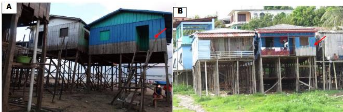
Figura 05 - Palafitas com marca da subida das águas do rio.
