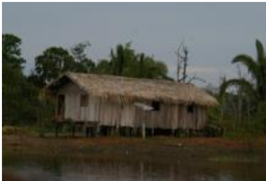
Figura 07 - Casas ribeirinhas tipo palafitas construída em terras firme.
