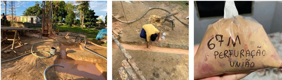
Figura 6 – Terreno da construção do poço, ponto de coleta do solo no circuito do fluido de resfriamento da broca, e amostra de sedimentos armazenada e identificada em um saco plástico, respectivamente.
