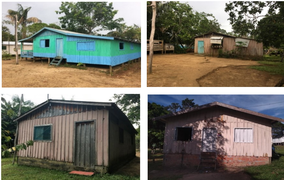
Figura 3 - Residências das famílias da comunidade São Sebastião do Saracá, RDS Rio Negro, Iranduba-AM. Fonte: A autora (2022).
