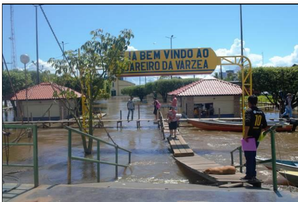
Figura 14. Plataforma de madeira sobre as ruas da cidade de Careiro da Várzea para passagem de residentes e visitantes.
