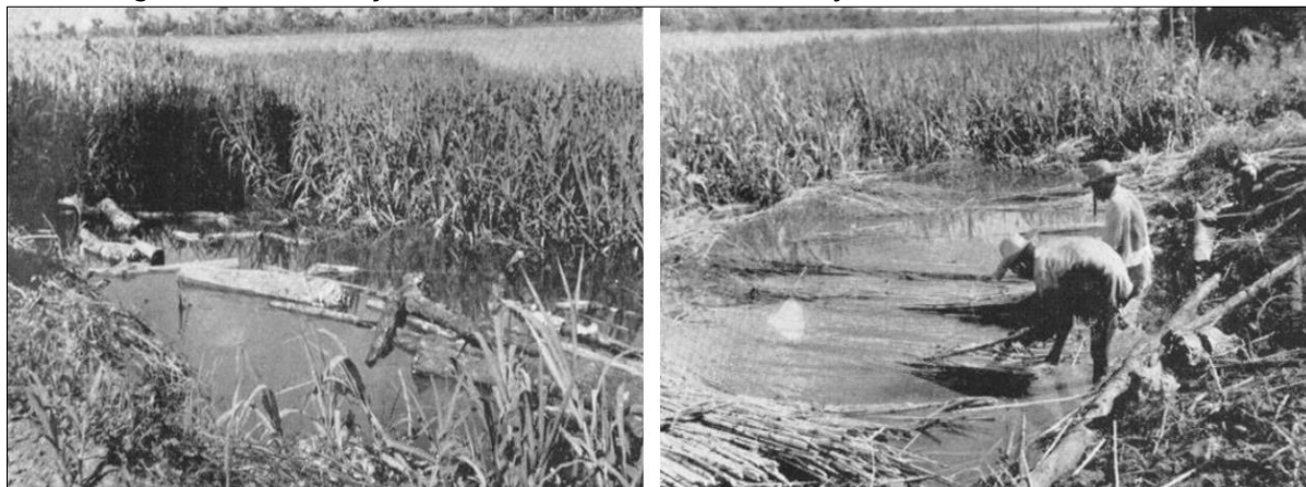
Figura 11 – Maceração nos rios da Amazônia e extração das fibras das hastes
