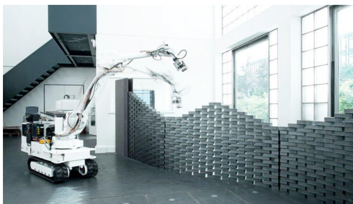
Figura 3 - Robô In situ Fabricator
