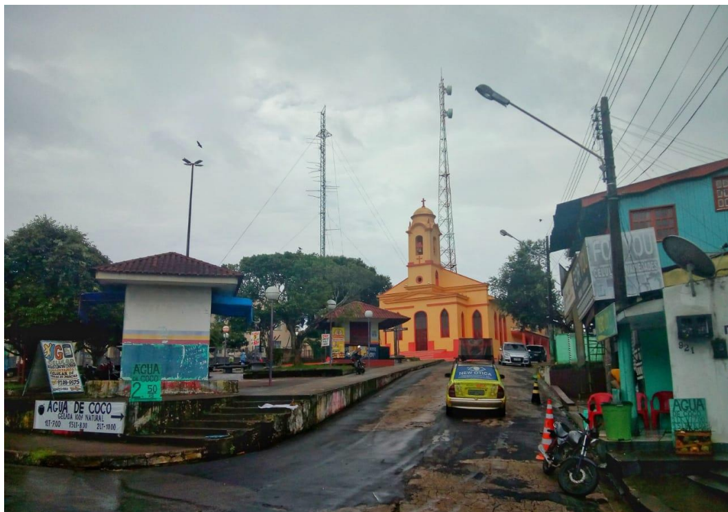
Figura 11 - Torres de telecomunicação em Manacapuru-AM;
