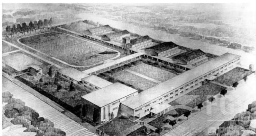
Figura 6 - IFAM/CMC - Maquete da edificação em 1934
