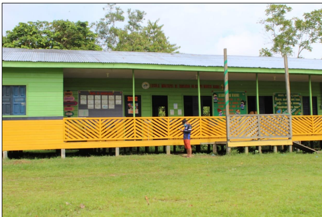
FIGURA 19 – Escola Municipal da Comunidade de São Pedro do Norte em Atalaia do Norte - AM
