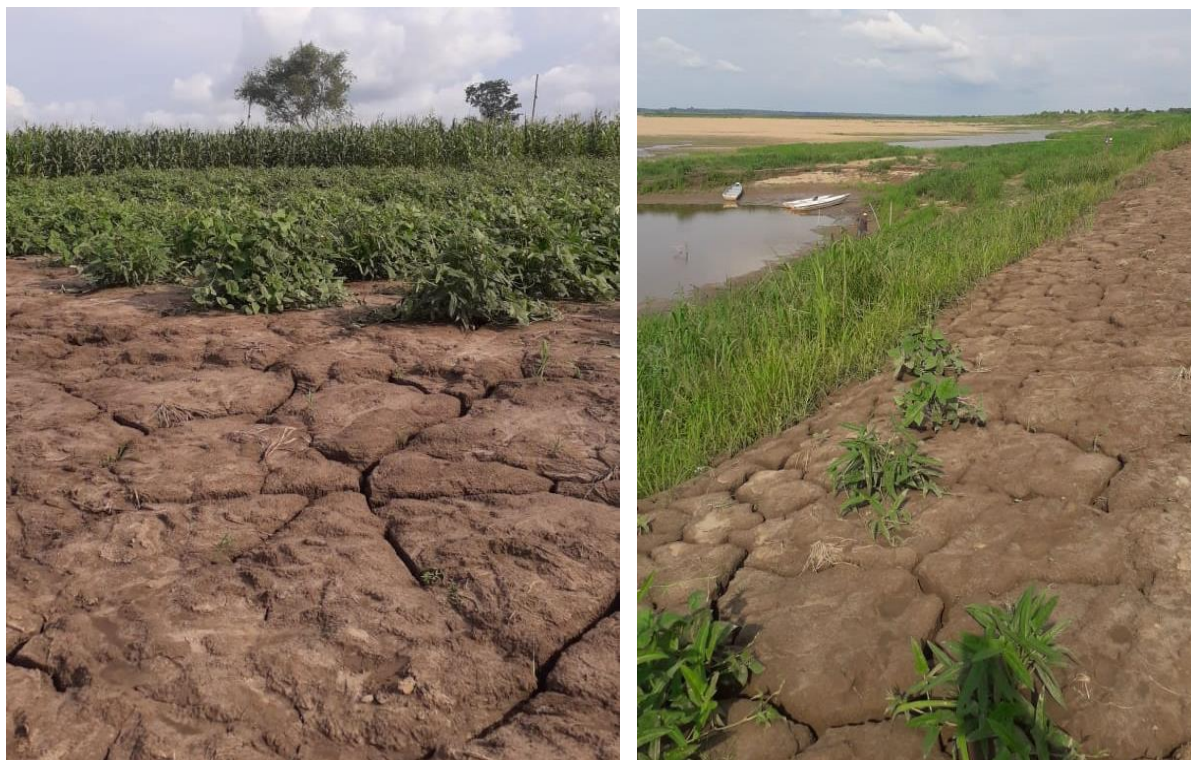
Figura 43: Características superficiais do solo com presença de rachaduras da área de estudo.
