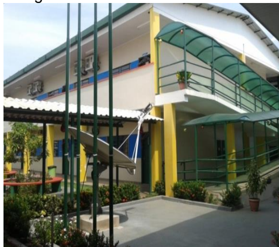
Figura 17 - Área Interna da Escola
