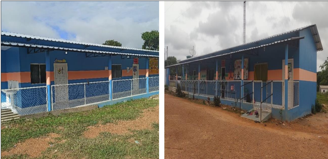
Figura 8: Prédio novo da escola de Santa Clara
