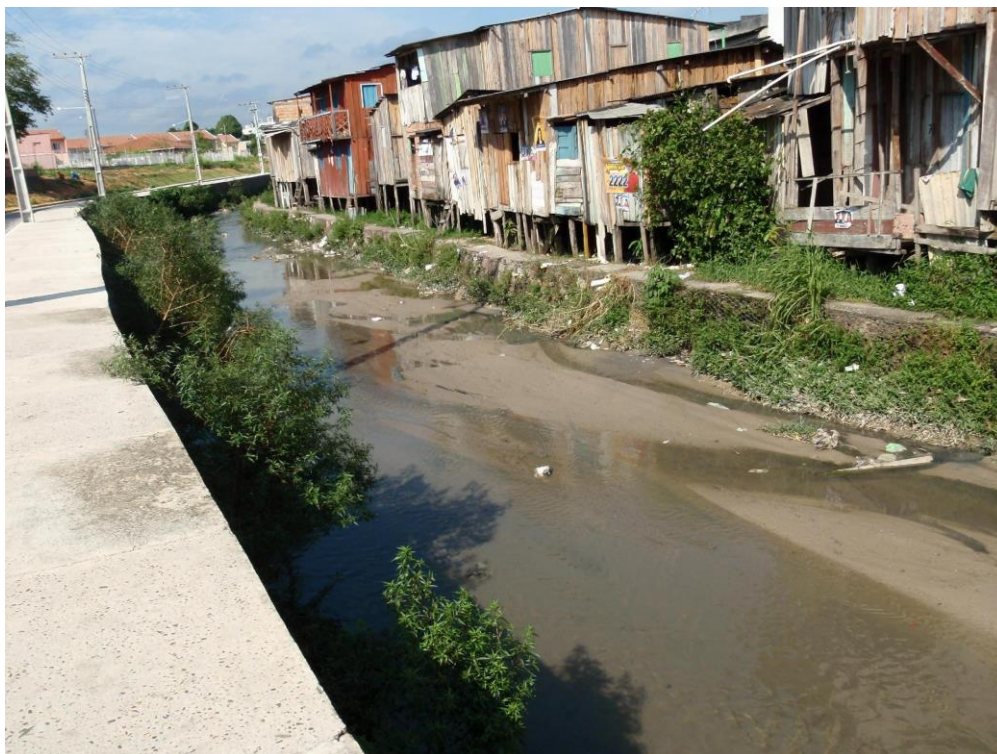
Figura 21- Processo de assoreamento no leito fluvial do igarapé do Bindá na BHSR. Foto: Tiago Fonseca Rodrigues.
