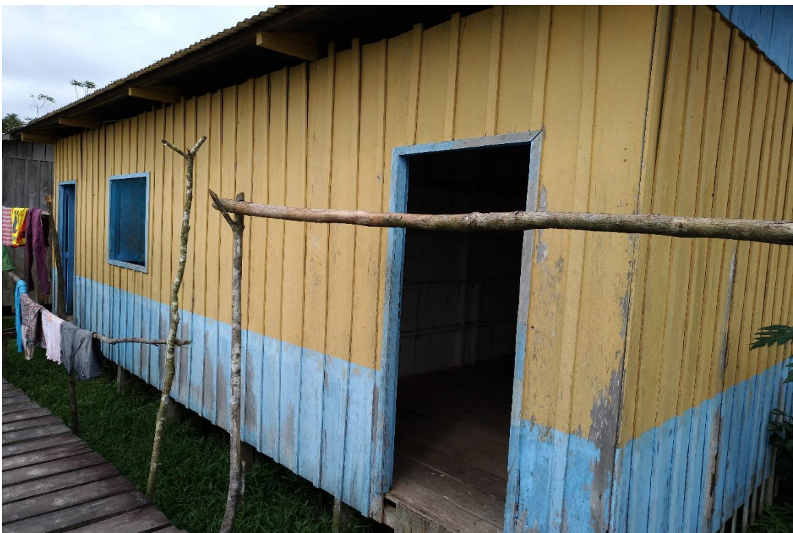
Comunidade: São Sebastião Escola Municipal: São Sebastião
