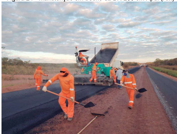
Figura 24 - Manutenção em trecho da BR-230 em Apuí (AM)
