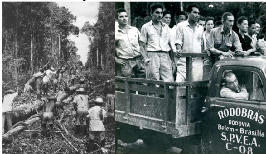
Figura 5 - Obras na Belém-Brasília
