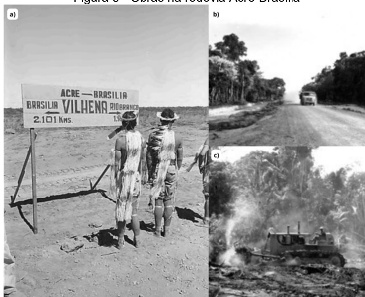
Figura 6 - Obras na rodovia Acre-Brasília
