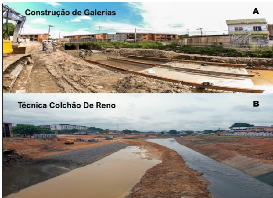
Figura 25 - Construção de Galerias e Técnicas de Gabiões Bacia Do Quarenta
