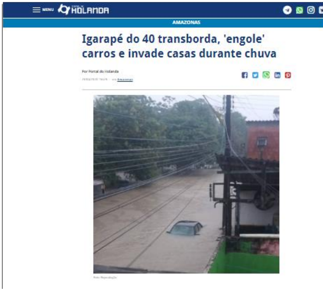
Figura 24 - Notícias publicadas Transbordamento do canal na rua Manaus 2000
