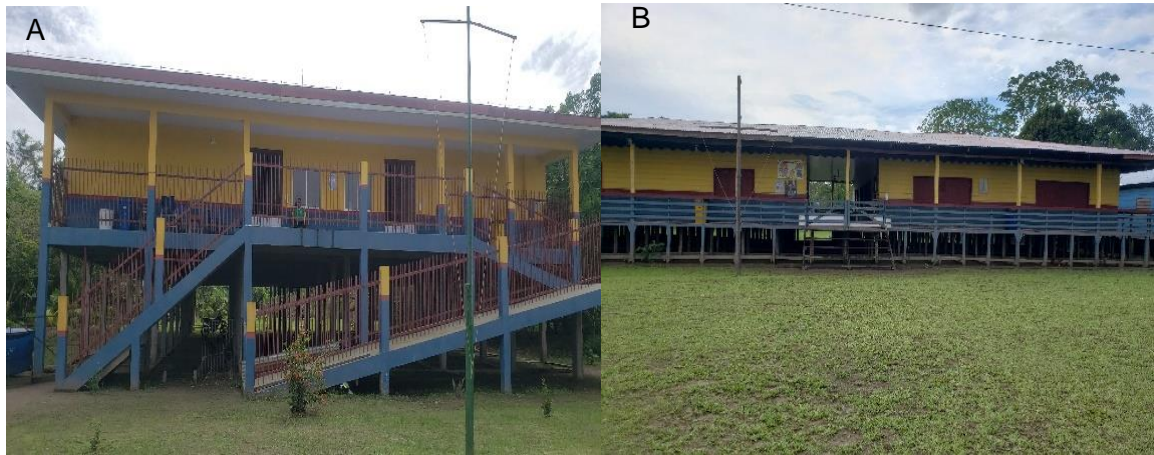
Figura 4- Faixada das Escolas Municipais das duas comunidades. (A) Escola Municipal de Limeira; (B) Escola Municipal de Teresina I
