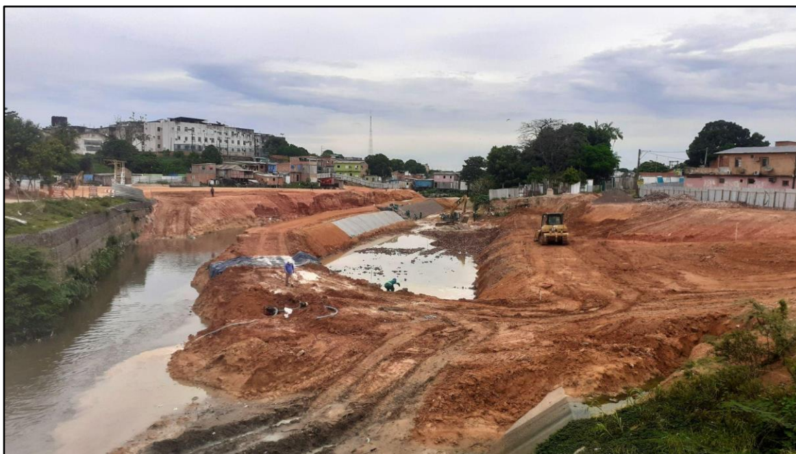
Figura 35: Canalização do Igarapé do Quarenta. Foto: Wesley Barbosa (Nov/2020). Nota: Vista a montante do canal.
