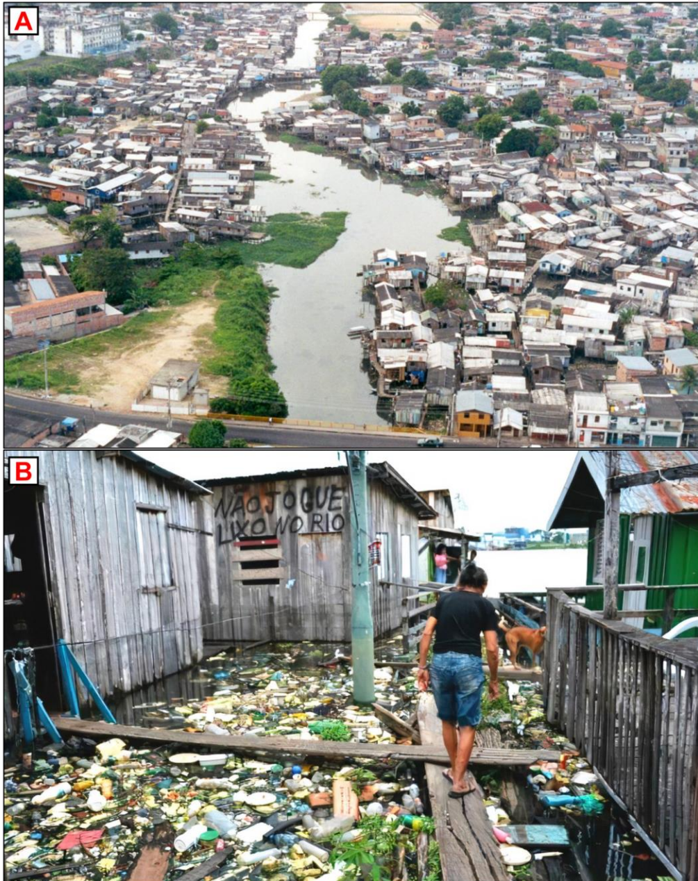
Figura 18: Palafitas e resíduos sólidos ao longo dos canais da bacia do Quarenta antes do PROSAMIM.
