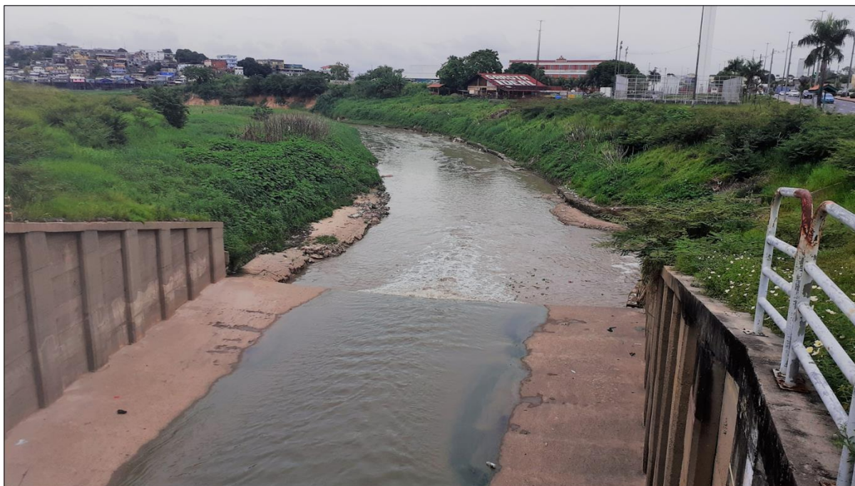
Figura 46: Trecho final do igarapé do quarenta impermeabilizado Foto: Wesley Barbosa (2020)
