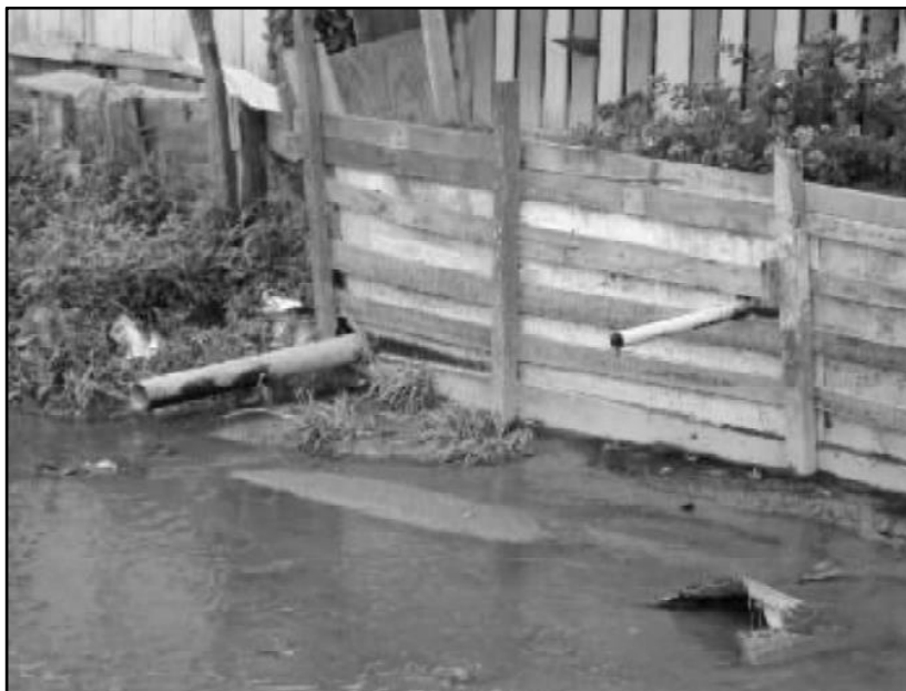
Figura 20: Lançamento de esgoto no igarapé do Quarenta antes do PROSAMIM Fonte: SEINF, 2004.
