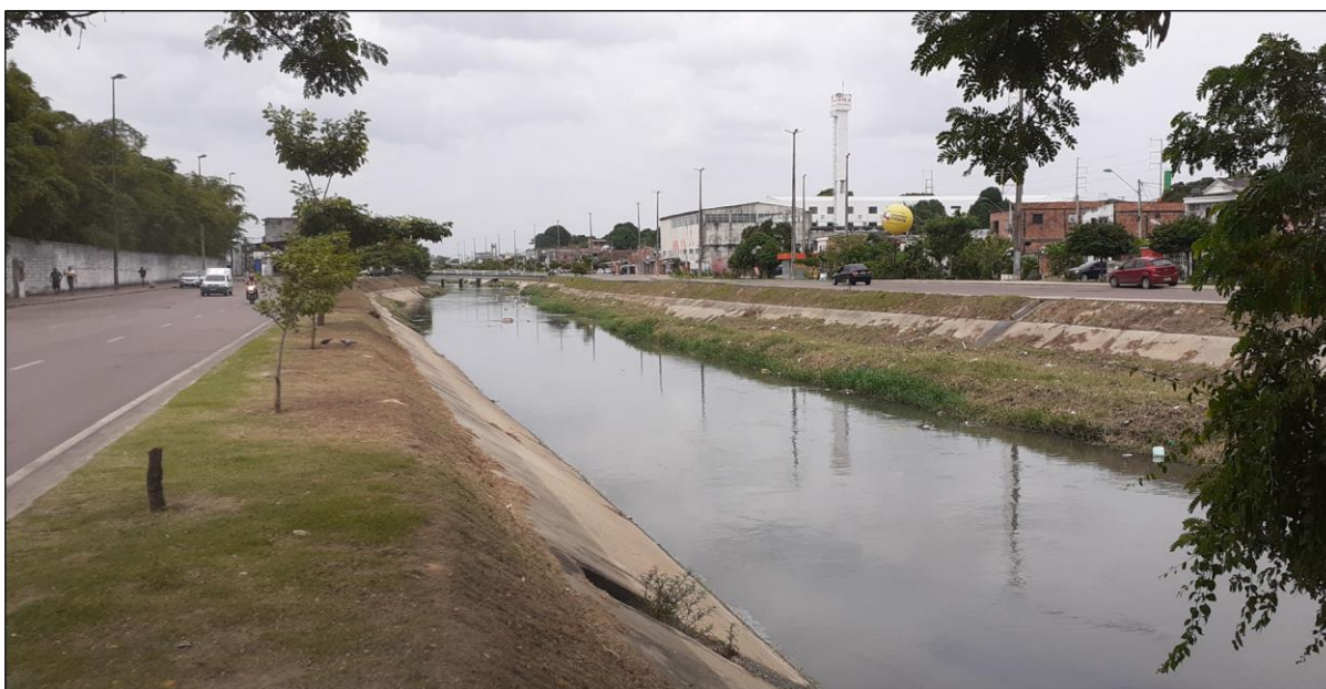
Figura 36: Igarapé do Quarenta (Canal Principal) após as obras do PROSAMIM Foto: Wesley Barbosa (2020).
