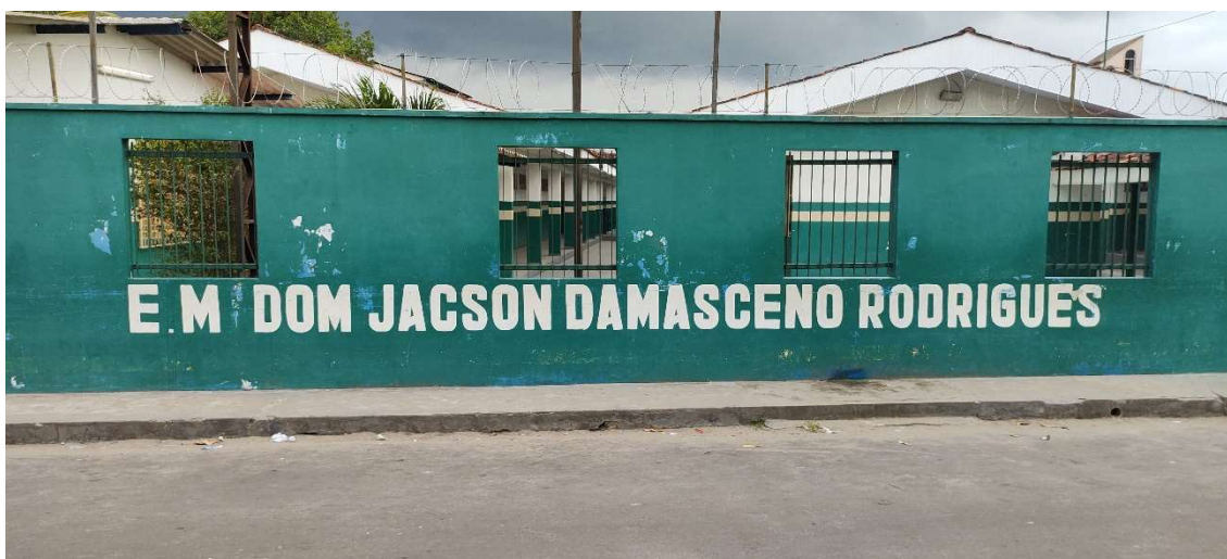
Figura 1: Frente da Escola Municipal Dom Jacson Damasceno Rodrigues
