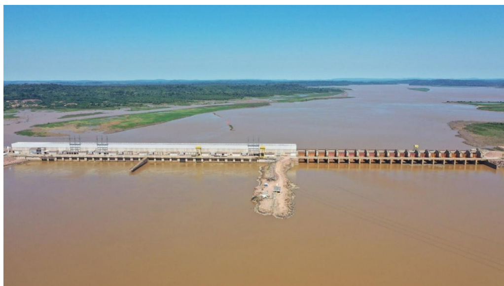
Imagem 2: Vertedouros da Hidrelétrica de Jirau.
