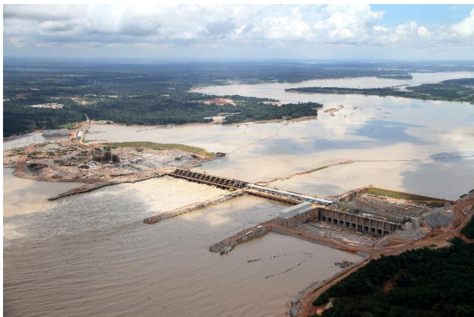
Imagem 1: Panorâmica da UHE Santo Antônio
