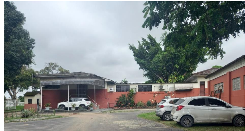
Vista do prédio onde funcionou a creche Ipê III.
