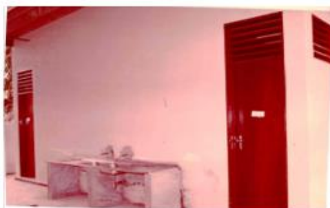
Construção da creche anexa à sede da LBA- Amazonas.
