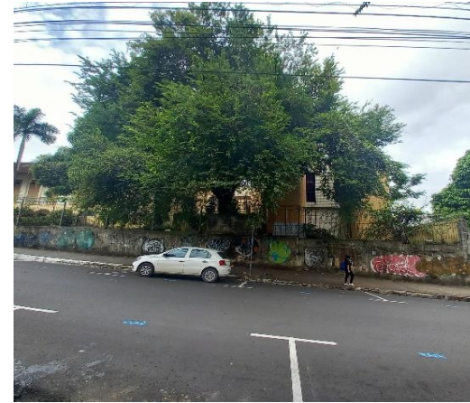
Vista da área externa de onde era a entrada para a Creche Ipê I pela rua 24 de maio.
