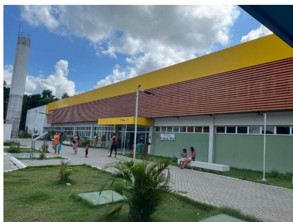
FIGURA 20 - FACHADA DO PRÉDIO DA ESCOLA DESTINADO AO ENSINO FUNDAMENTAL
