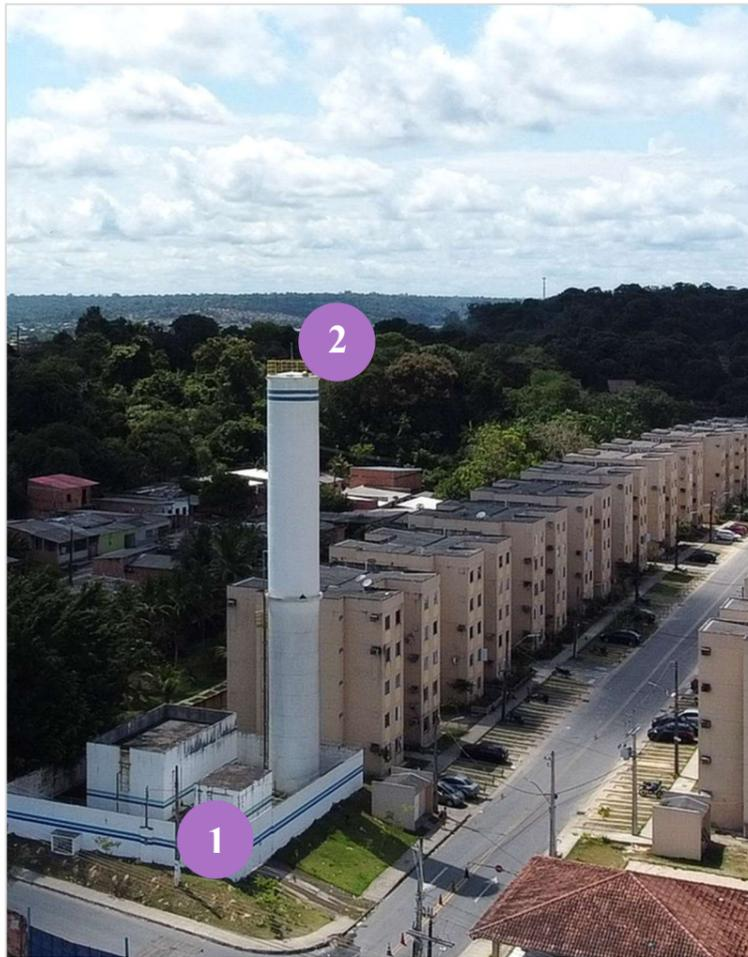
**Figura 47** – Reservatório para abastecimento de água
