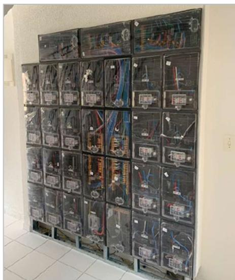
**Figura 71** - Medidor individuais de energia elétrica
