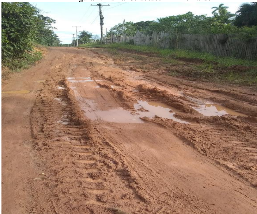
Figura 4: Ramal de acesso PA Rio Pardo
