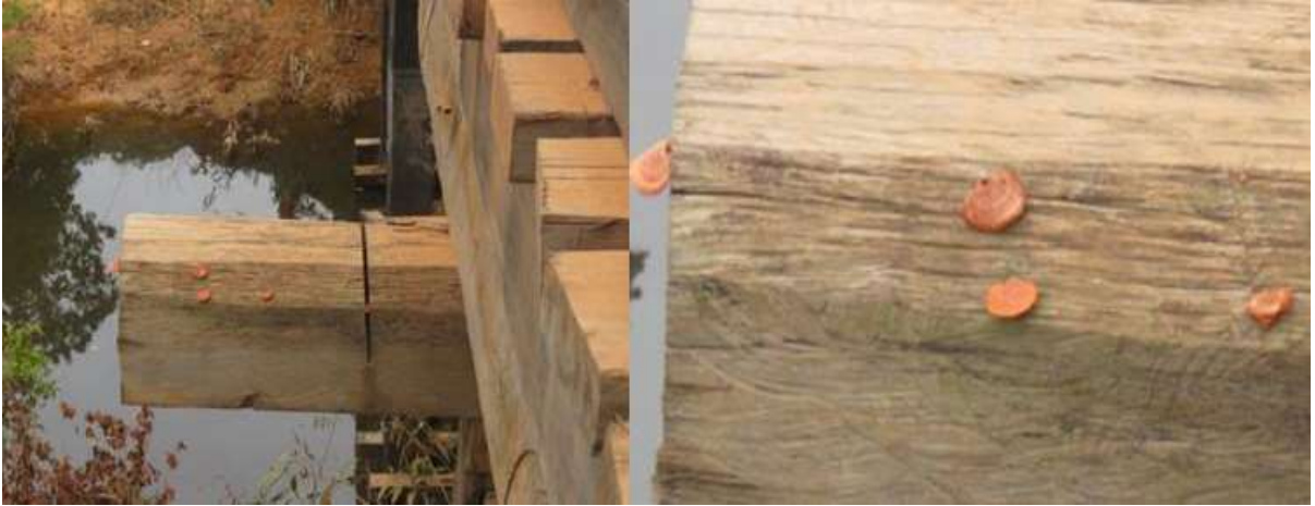
Figura 21 – Estrutura Guarda-rodas atacada por Pycnoporus sanguineos
