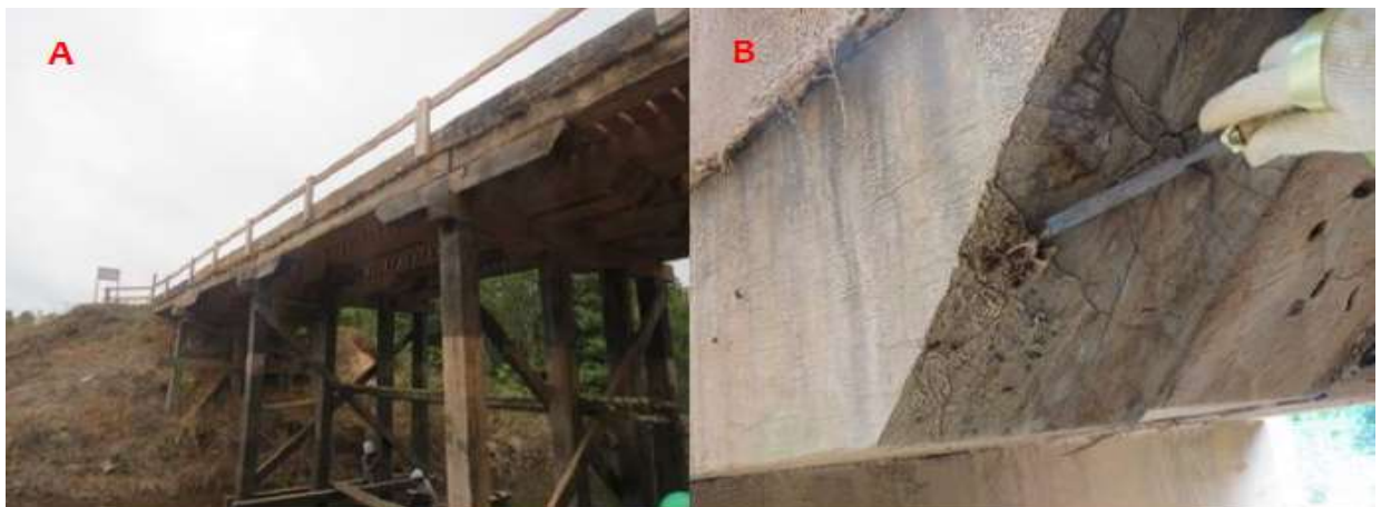
Figura 12 – Aspecto geral da ponte do Igarapé Beleza
