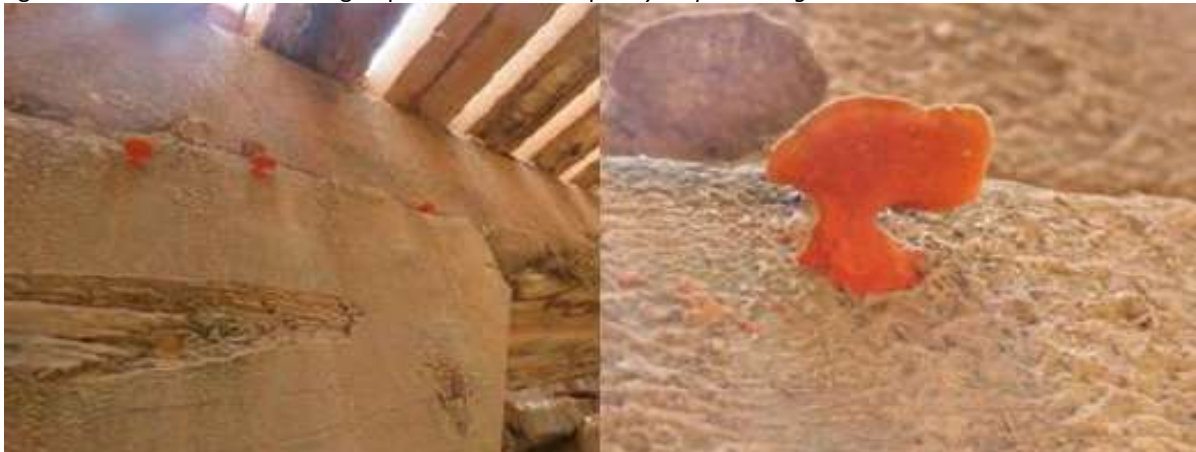
Figura 17 – Balancim da Ponte Igarapé Beleza atacada por Pycnoporus sanguineus
