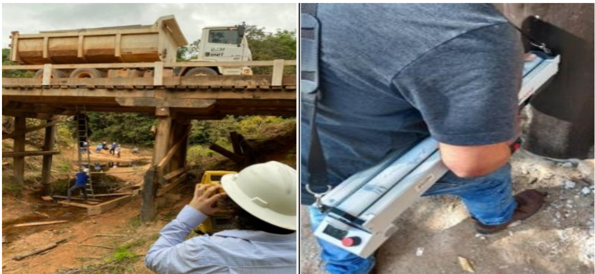
Figura 8 – Medição do deslocamento das longarinas com a estação total e resistência interna
