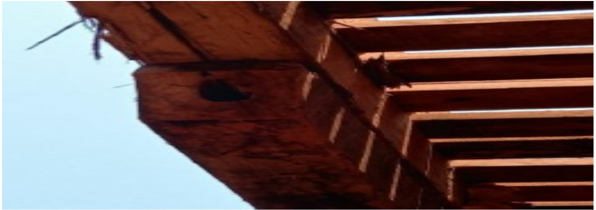
Figura 14 – Peça de madeira com defeito “ocada”
